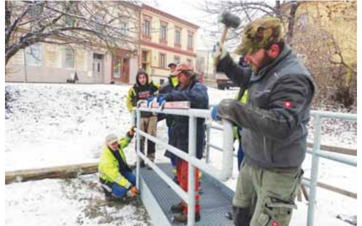
Ztrouchnivělé dřevěné prkno přes Pokratický potok nahradil nový kovový mostek. Foto: Radim Tuček
