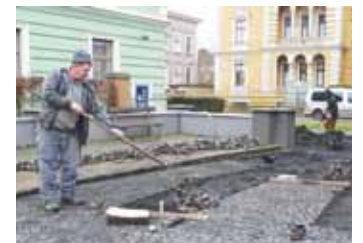
Pokládka nového chodníku u posezení nacházejícího se poblíž ZUŠ. Nyní již je hotovo. Foto: Radim Tuček
