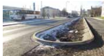
Levá polovina komunikace je opravená, na jaře přijde na řadu pravá část.
